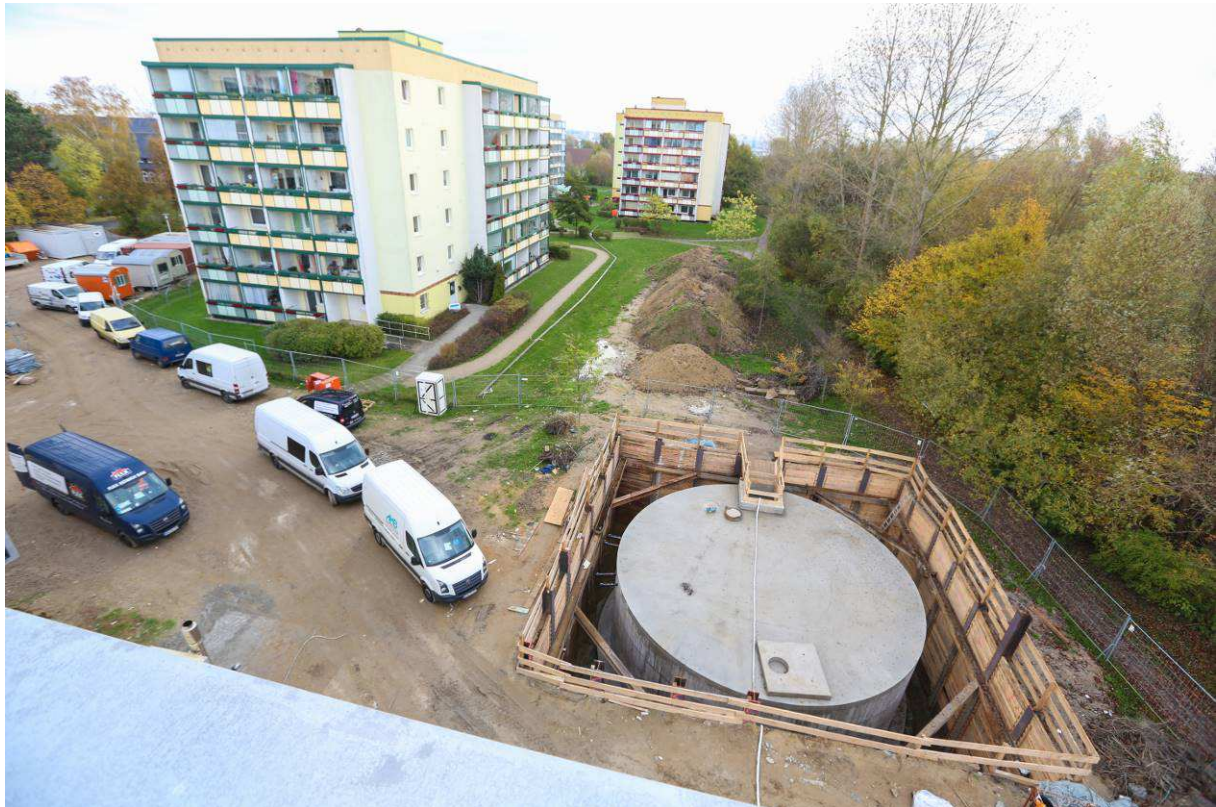
3 – Der Betonzylinder des Speicherkörpers fasst insgesamt 316.000 Liter Wasser.
