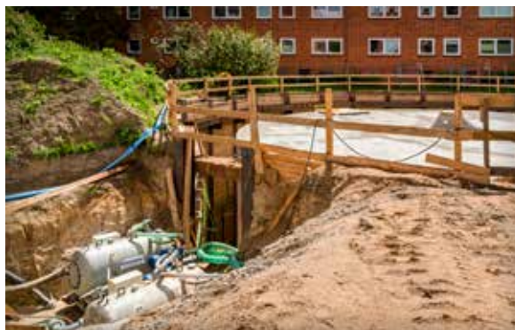
140 Wohnungen zwischen Beethoven-, Franz-Schubert- und Lortzingstraße werden bald mithilfe von Eis beheizt. Ein monumentaler Eisspeicher im Innenhof, Wärmepumpen und Solar-Absorber auf den Dächern sorgen demnächst für CO 2 -neutrale Wärmeversorgung.
