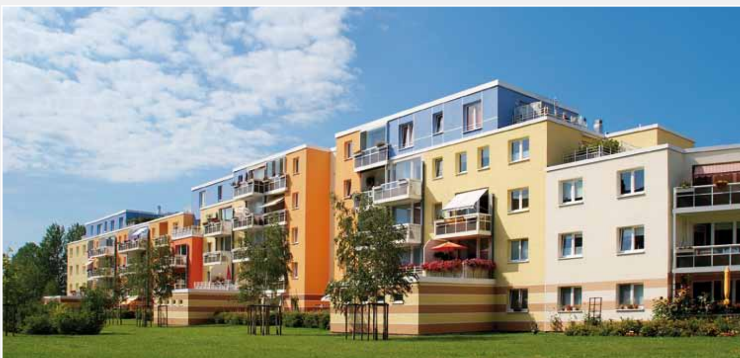
Stadtumbau Ost: Der Ahornhof in Rostock Groß Klein – aus Fünfgeschossern im Plattenbaustil der DDR entstand bis 2002 durch Umbau eine komfortable Wohnanlage.
