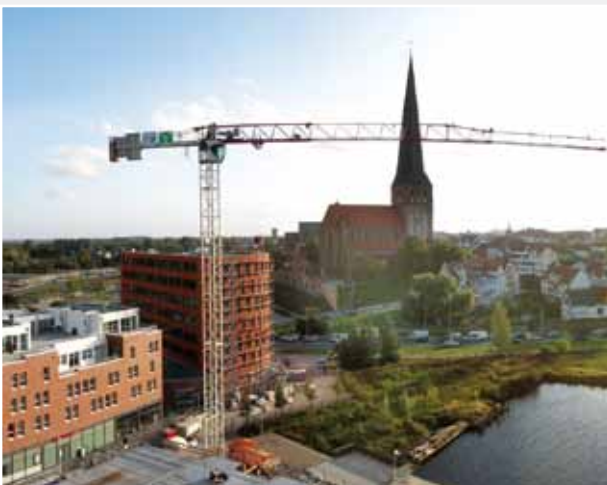
Ein neues Viertel entsteht: Die WIRO erschließt die Rostocker Holzhalbinsel.
