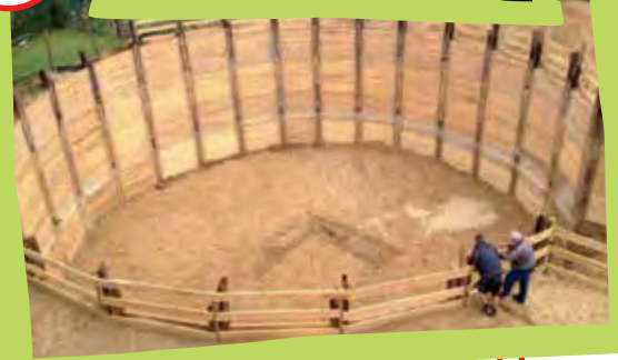
Großes Loch buddeln, Speicher montieren, Rasen pflanzen – am Ende sieht man vom unterirdischen Eisspeicher nix.
