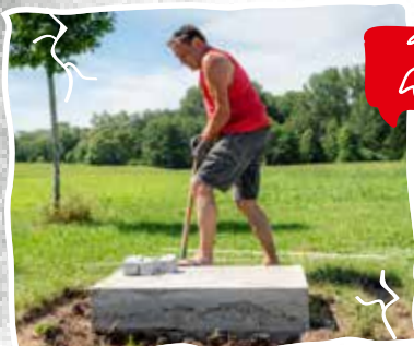
Reiner Bloch ist zuständig fürs neue Fundament.
